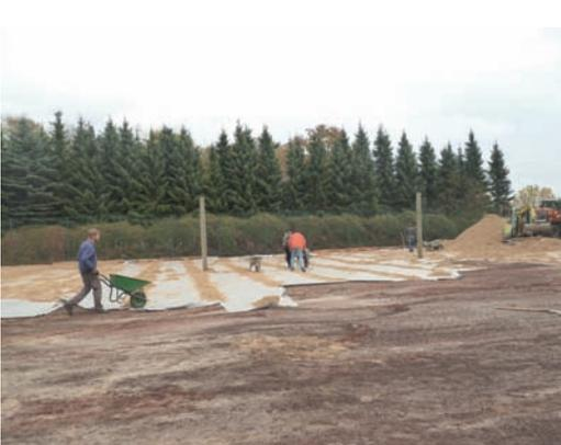
Außerdem haben wir zusammen mit den Volleyballern die Verlegung der Beachplätze gestartet. So wurde mit großem Gerät die „rote Asche“ von den alten Tennisplätzen entfernt, die Umrandung wurde von Unkraut befreit, Tore und Pfosten wurden aufgestellt, Vlies verlegt und der Sand wurde schon teilweise verteilt. Es wartet noch genügend Arbeit auf uns, aber im nächsten Jahr werden wir die Plätze auf jeden Fall nutzen können.
